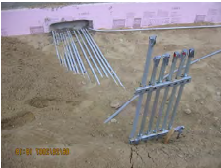
Conduits for Gas Pumps
